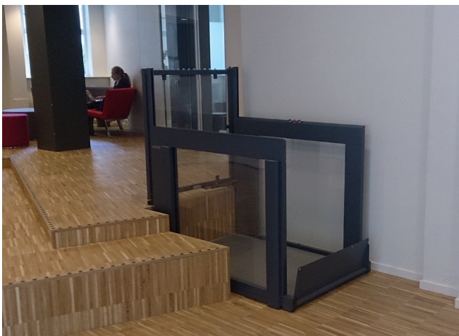
Bürozugang auf oberer Halbetage
